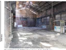
Vue intérieure du bâtiment au niveau de la plateforme
