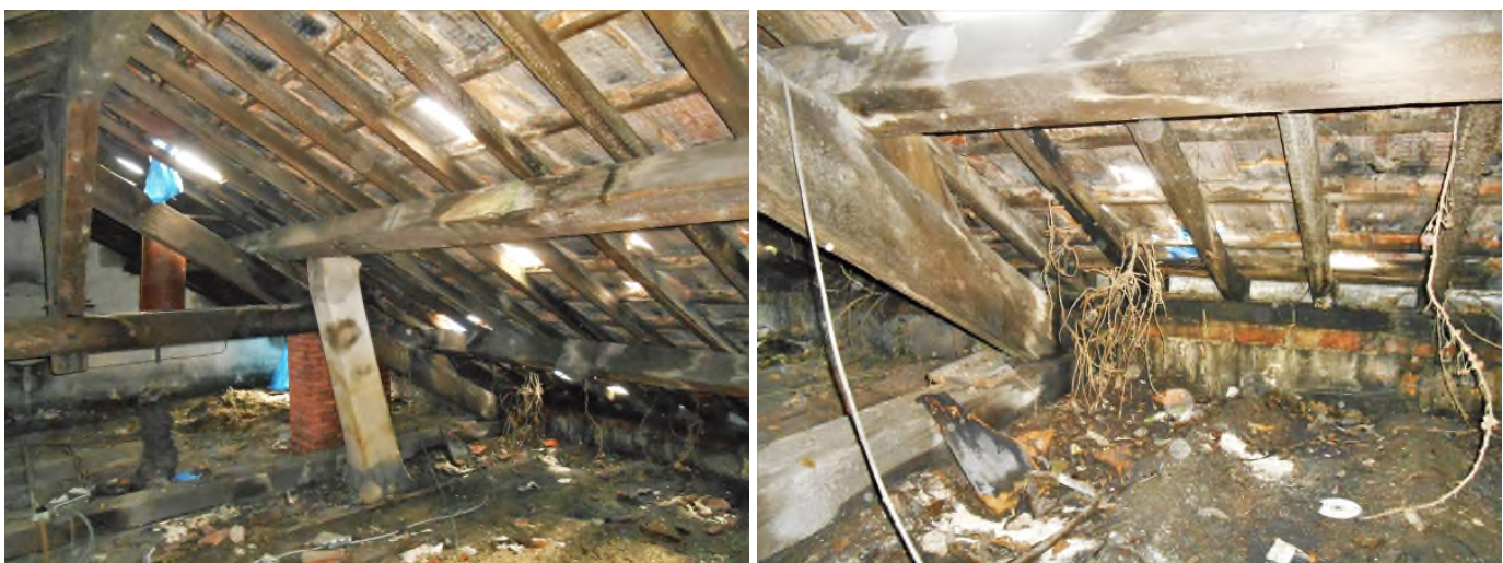
Etat actuel des combles : Plancher gorgé d'eau, plantes passant à travers les tuiles, débris...
