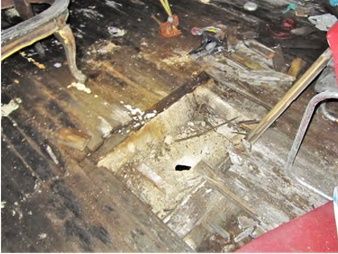
Plancher et plafond détériorés par les infiltrations d'eau
