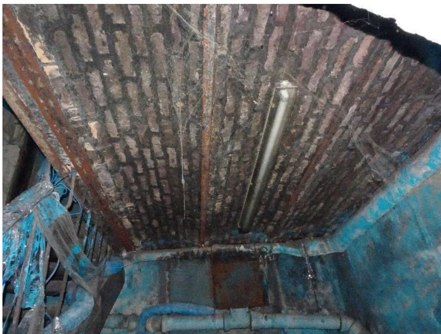
Figure 4 - Vue du plancher bas du RDC depuis le sous-sol.
