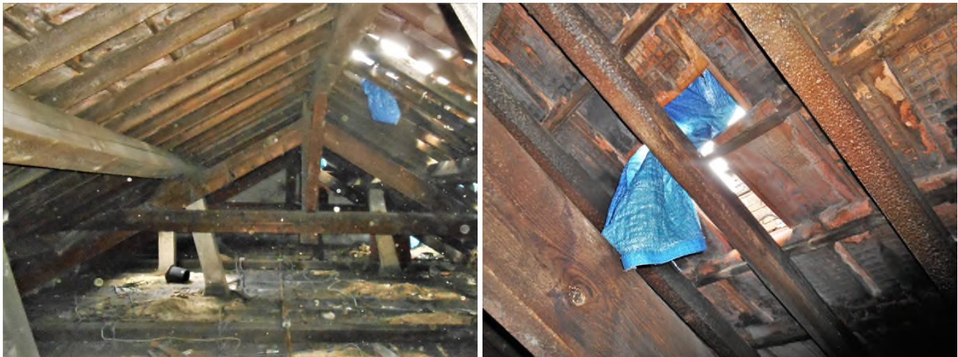
Etat actuel des combles : Couverture percée, bois abîmés...
