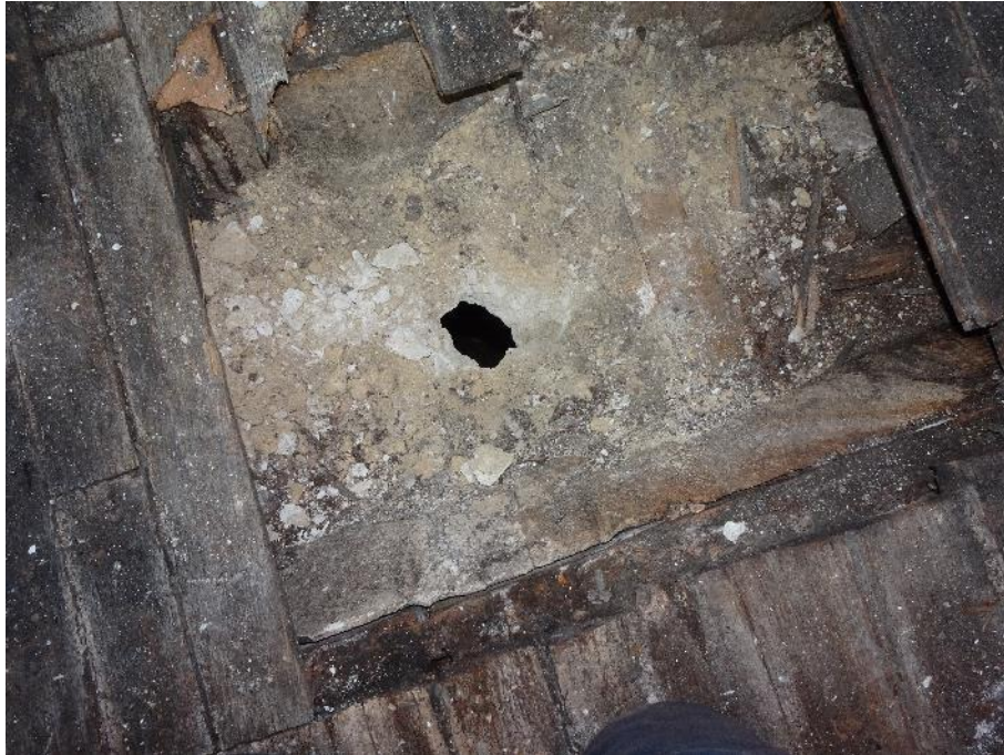
Figure 3 - Reconnaissance du procédé constructif du plancher bas du R+1
