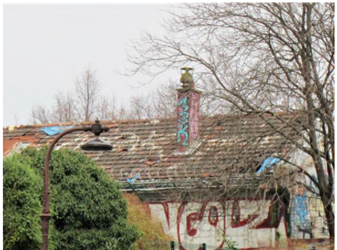
Vue extérieure du rampant Ouest
