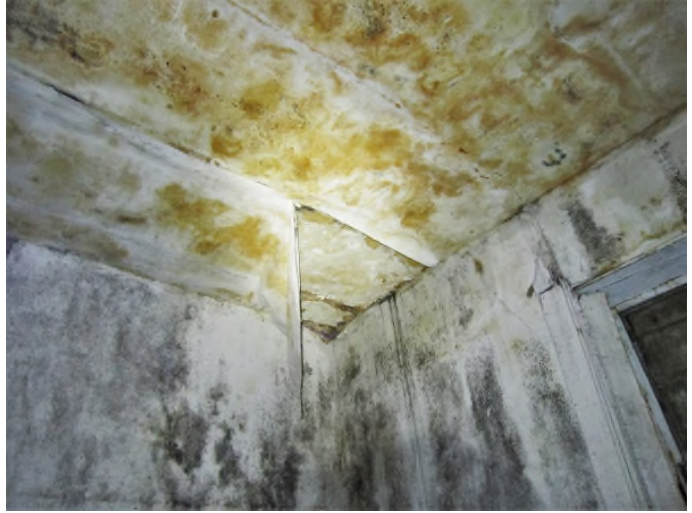
Plancher et plafond détériorés par les infiltrations d'eau
