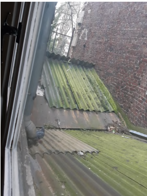
Appentis côté rue du Hameau : Poutre bois très abîmée et couverture en fibrociment
