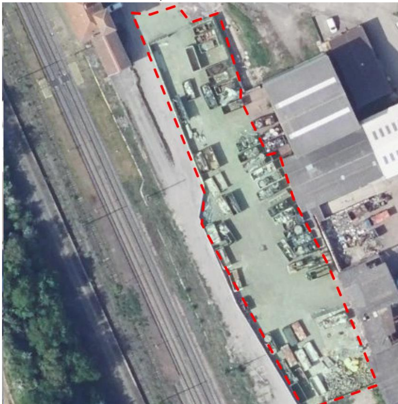
KEDANGE-SUR-CANNER 000966M-T004 Environ 2700m 2 Section 4 n°0317p Dépôt de bennes vides
